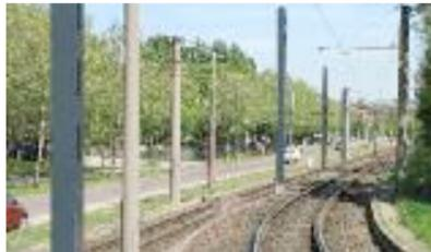
Auf dem Streckenabschnitt zum Wiesenhügel wird die Erneuerung der Fahrleitung nötig. Im ersten Bauabschnitt wurden vom 18. bis 21.04.2011 die neuen Fahrleitungsmasten aufgestellt. Der Neubau der Fahrleitungsanlage erfolgt im zweiten Schritt zeitgleich mit der ersten Wochenendsperrung Kranichfelder Straße im Rahmen einer Sperrpause des Stadtbahnbetriebes in den Sommerferien. Die neue Anlage erhöht die Versorgungssicherheit und hilft, Energie einzusparen.
